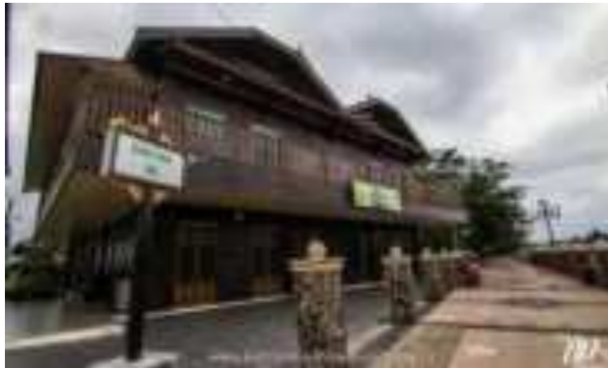
Gambar 4.3 Rumah Anno 1925 setelah renovasi
