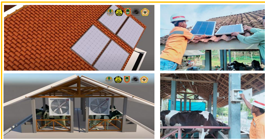
Gambar 4. Inovasi SI SAPI LEMU (Sistem Pengendali Kelembaban dan Suhu) di SAMARA FARM
