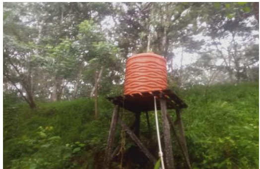
Tandon penampungan air dari embung
