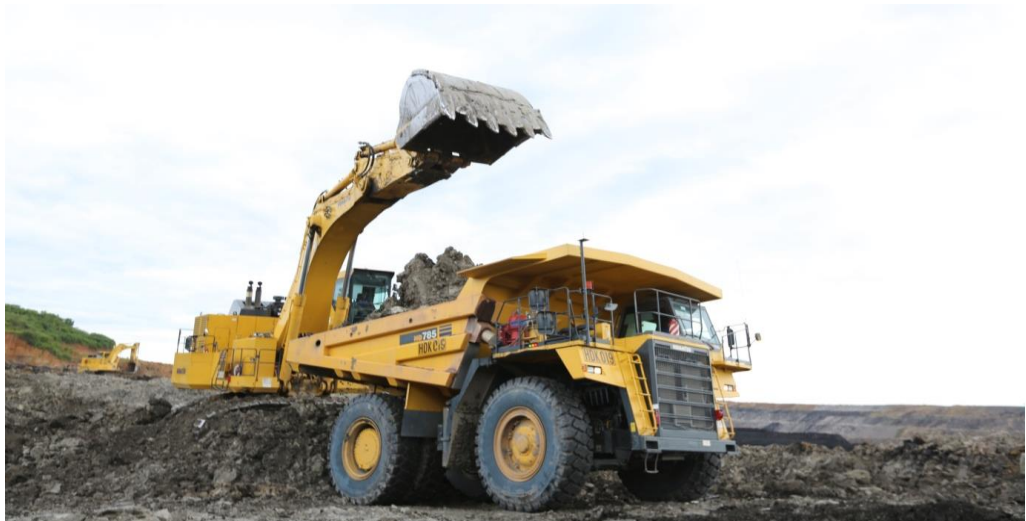
Gambar Proses pengalain overburden, pengangkutan dan penimbunan dilokasi disposal
