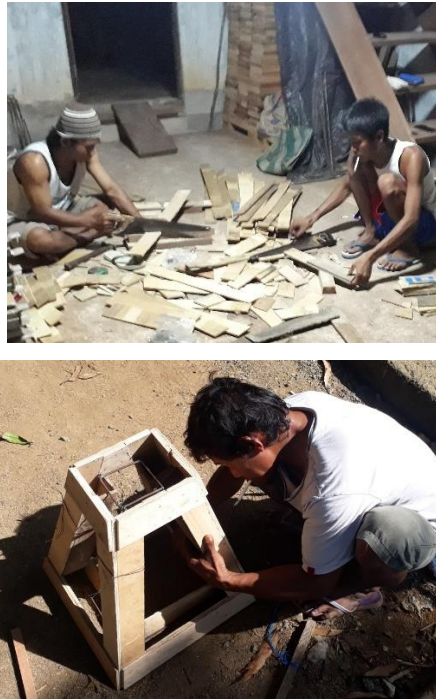
Gambar 7.3 Cetakan beton piramid dan pemasangan rangka besi
