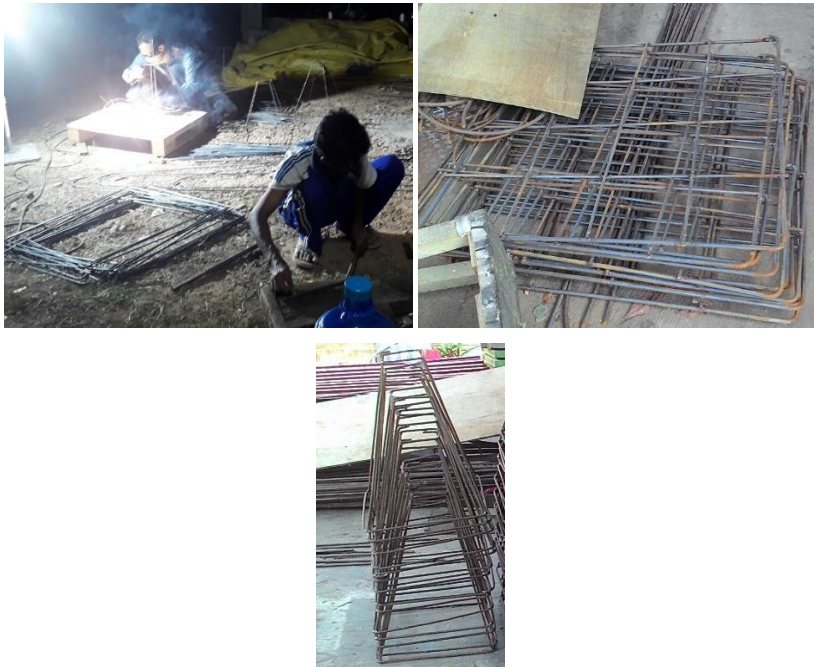
Gambar 7.5 Pembuatan rangka besi piramid dan frame kotak bersekat
