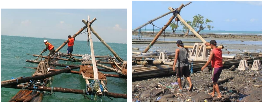
Gambar 8 Pengangkutan beton terumbu buatan menuju rakit
