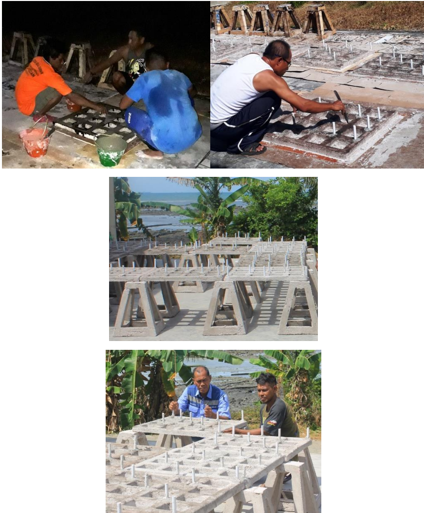
Gambar 7.7 Beton frame kotak bersekat
