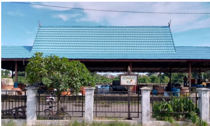
Gambar 3.1. Tampak depan TPI Air Tawar Kota Banjarmasin
