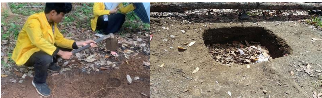
Gambar 2 Household sanitary landfill yang dibuat di pekarangan rumah warga
